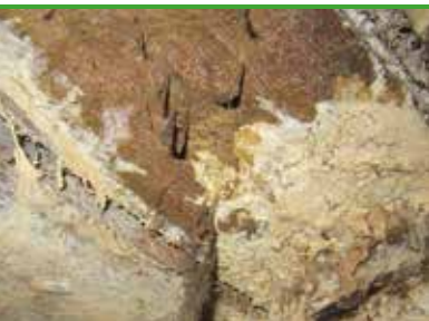
sv 20 Källarkantarell currygult tunnsträngad ytmycel (foto - Bøgh & Helstrup)
