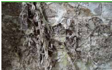
svn 26 Äkta Hussvamp - äldre, grått ytmycel med strängmycel (foto - Protox)
