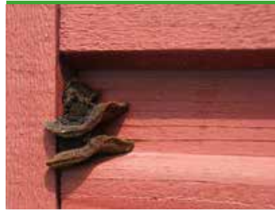
Korkmussling - fruktkroppar på träfasad, frittidshus (foto - Protox)
