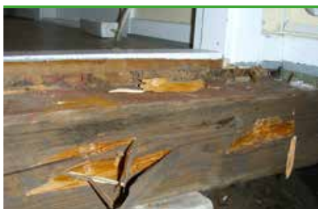
svn 41 Pulverskinn - balk med intakt yta. Angripen inifrån (foto - Goritas)
