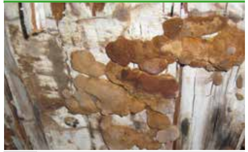
svn 14 Korkmussling - steril fruktkropp utvecklad i mörker (foto - Goritas A/S)
