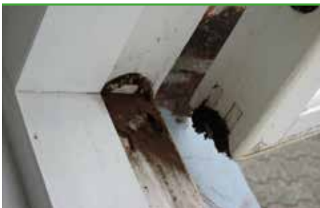
svn 23 Slemsvamp - moget, brusten fruktkropp med sporpulver (foto - Protox)
