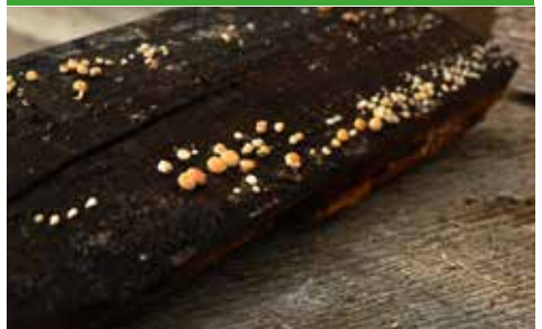
svn 16 Rotplätt - fruktkroppar på takfotsbräda (foto - Protox)
