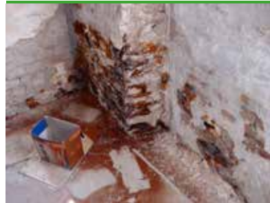
Äkta Hussvamp - sporpulver på golv (från fruktkroppar på vägg) (foto - Protox)
