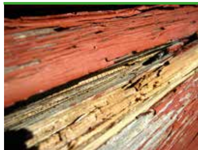
Korkmussling - nedbrytning med typisk bladning av årsringarna. Timmerstuga (foto - Protox)
