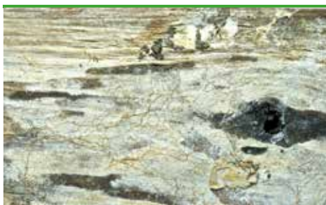
svn 40 Skinnsvamp – Knölsporigt Stjärnskin på virke i källare (foto - Protox/Goritas arkiv)
