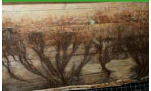
svn 32 Pulverskinn- brunt strängmycel på limträsbjälke (foto - Protox)
