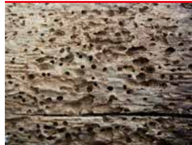
Skäckig trägnagare - flyghål i gammal balk (foto - Protox)
