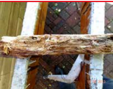
i 16 Gulröd blombeck i dörrstolpe - larv och larvgångar med borrmjöl. Se även sidan 19 (foto - Protox)
