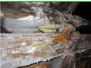
sv 14 Timmerticka- fruktkroppar och ytmycel (foto - Bøgh & Helstrup)
