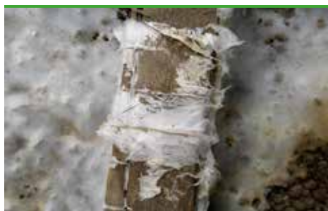
svn 27 Äkta Hussvamp- ungt ytmycel med strängbildningar, läkt i uterum (foto - Protox)
