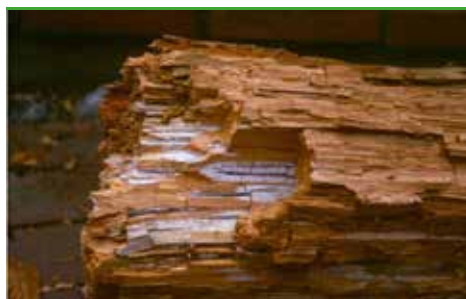
svn 45 Mögelticka - nedbrytning och vitt ytmycel på brytytor (foto - Goritas A/S)
