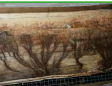
sv 7 Pulverskinn - mörkbrunt buktande strängmycel på limträbalk (foto - Protox)
