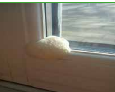
sv 39 Slamsvamp - ung fruktkropp i delaminerad fönsterkarm (foto - Protox)
