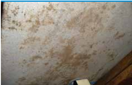
skn 9 Mögelpåväxt på diffusionstätta undertak (flityta) (foto - Protox)
