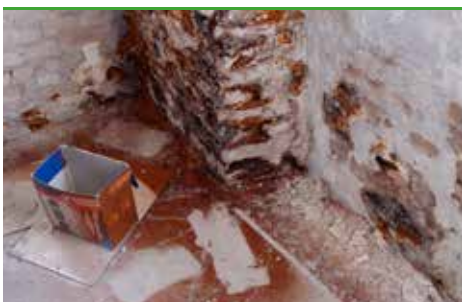
svn 5 Äkta Huskvamp - rödbrunt sporpulver på golv (foto - Protox)
