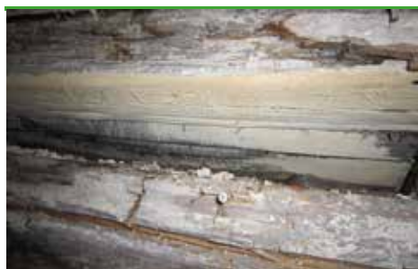
svn 9 Mögelticka - fruktkroppar och mycel på angripet virke med sprickklossar (foto - Bøgh & Helstrup)
